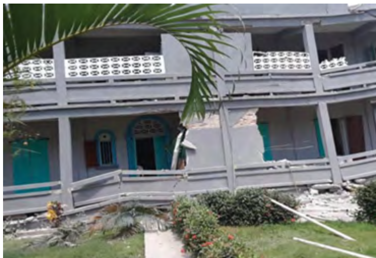
Au passage du séisme, le rez-de-chaussée s'écarte et s'aplatit en cédant l'assise aux deux étages. – Photo : Rosette Lafortune, m.i.c.
