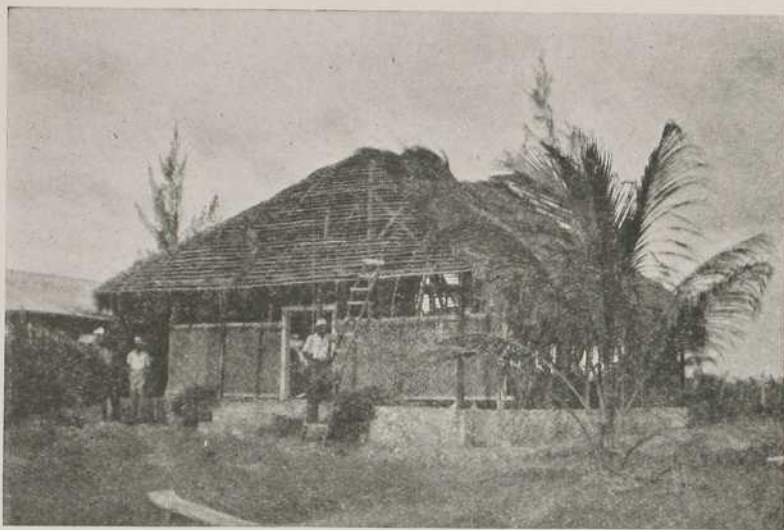
L'ÉCOLE EN CONSTRUCTION À L'ŒUVRE DE « LA CHARITÉ, S'IL VOUS PLAÎT »
