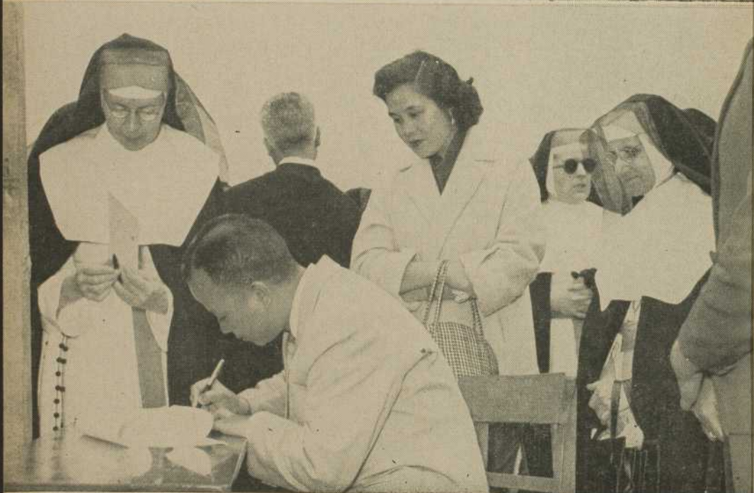
EN CONSTRUCTION : LA FUTURE ÉCOLE DES SŒURS MISSIONNAIRES DE L'IMMACULÉE-CONCEPTION, CLEAR WATER BAY ROAD, KOWLOON, HONG-KONG. AVANT LA BÉNÉDICTION DE LA PIERRE ANGULAIRE, LE 25 MARS 1955, L'ENTREPRENEUR, M. LEE, SIGNE LE DOCUMENT TRADITIONNEL. AU SECOND PLAN. SŒUR SAINT-LAZARE (JULIETTE RAINVILLE, DE BEAUPORT), SŒUR JEANNE-MARIE (JEANNE BRASSARD, DE MONTRÉAL), SŒUR SAINT-VIATEUR (AURORE LAPOINTE, DE MONTRÉAL).
