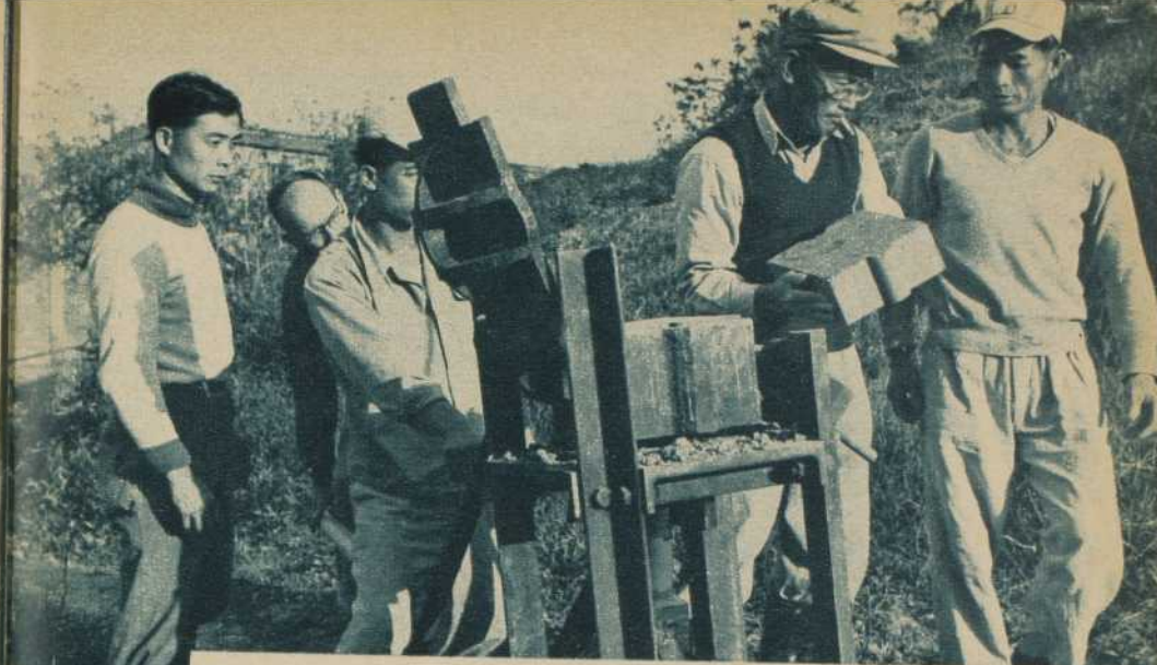
En opération. Une machine Ellson pour la fabrication, à la main, des blocs de ciment. 600 briques de ciment, équivalant à 3,000 briques ordinaires, sortent par jour de cette machine.
