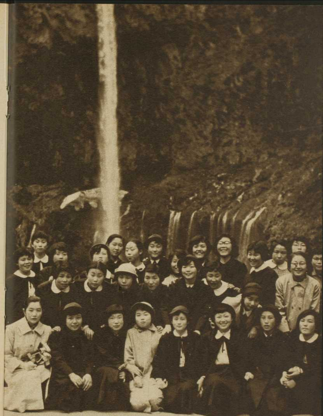
Au pied de la chute Kagon.
