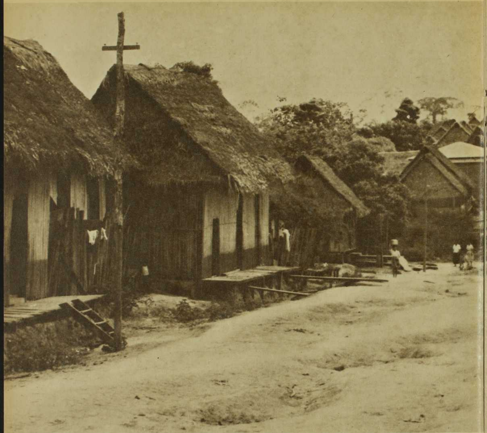
Rue de Pucallpa. L'habitation est le problème numéro 1 de la ville.
