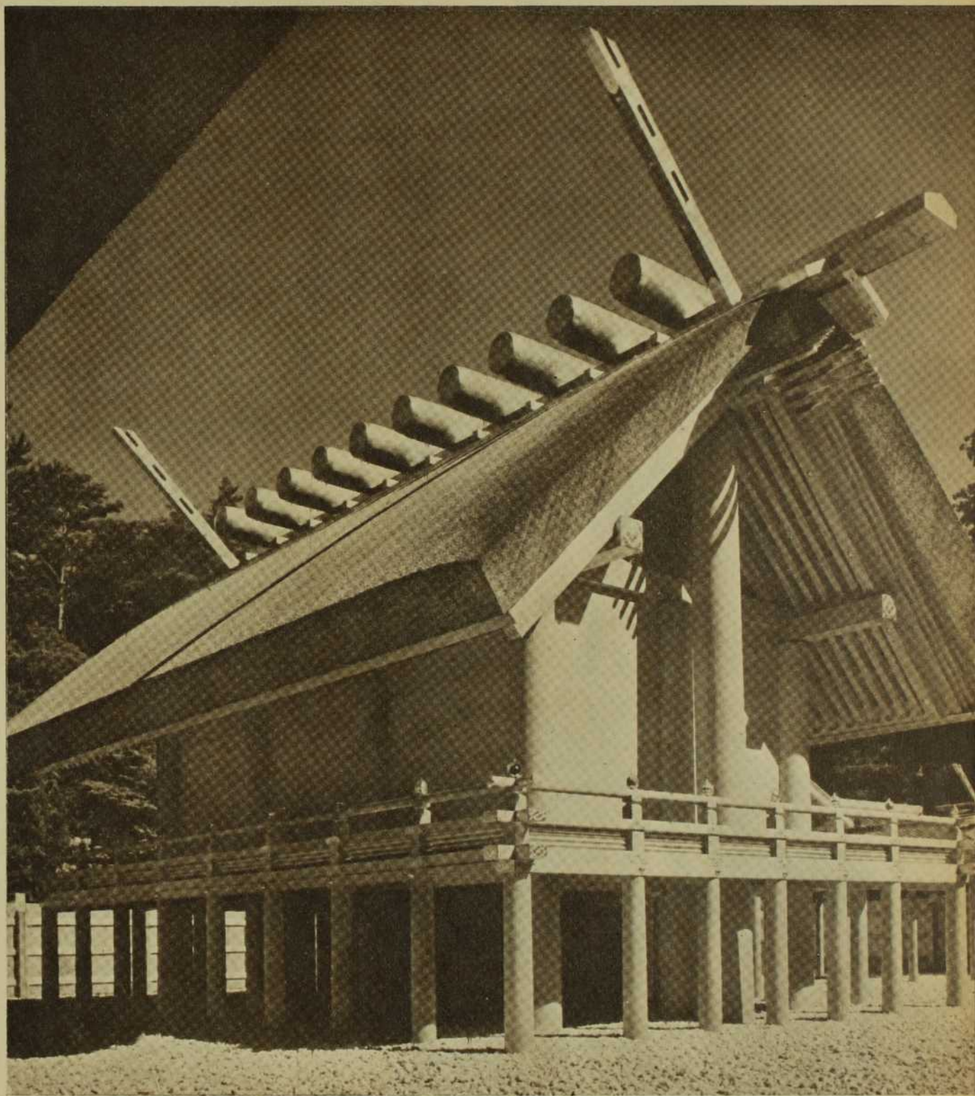
Le merveilleux toit de paille du temple d'Ise.
