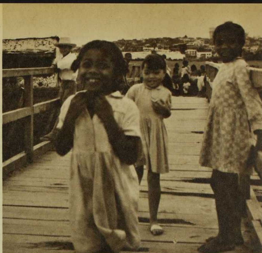
Le vieux pont de bois qui enjambe le canal.
