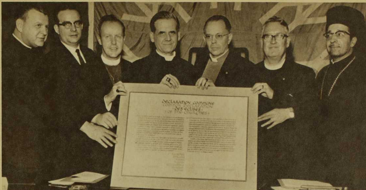
Photo historique prise en décembre 1964, lors de la déclaration commune des représentants officiels des sept premières confessions qui se sont unies pour bâtir ensemble le pavillon chrétien, témoignage vivant de charité fraternelle à la face du monde.
