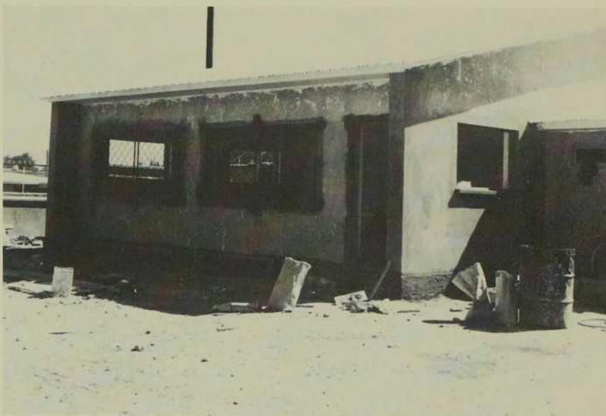
Construction d'un atelier pour les filles à Escuela Inmaculada Concepcion.
