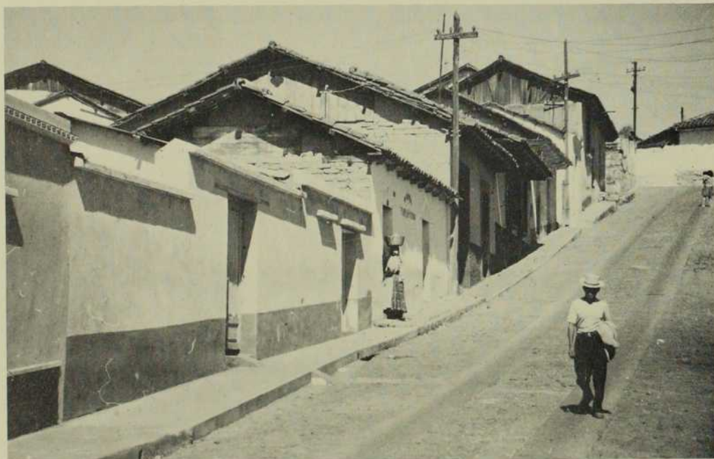
Une rue paisible avant le séisme.
