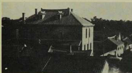
Façade nord de notre maison de Süchow.
