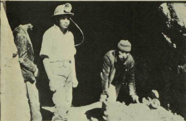
... prêt pour entrer dans la mine
