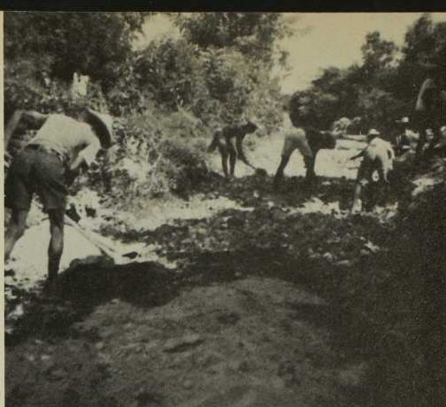
La route Carpentier-Rosiers en construction
