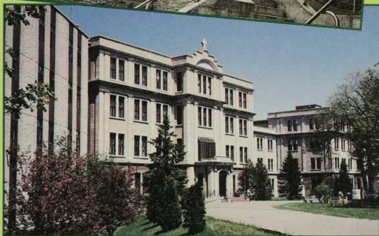
Pont-Viau, Laval - Bureau de la Presse Missionnaire M.I.C.
